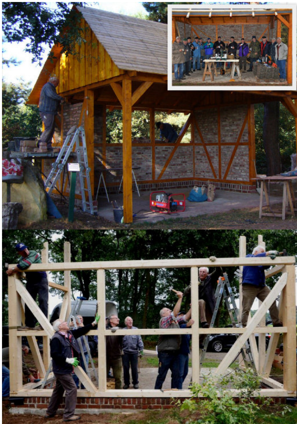
Mit vereinten Kräften wird das Fachwerk errichtet und Steinchen für Steinchen die Gefache ausgemauert. Eine erholsame Pause (kl.Foto) gehört dazu.
