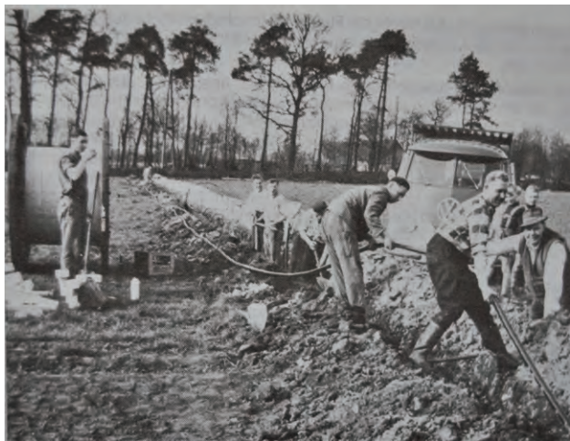
Arbeitseinsatz im Jahre 1959 zur Erdverkabelung der Freileitung
